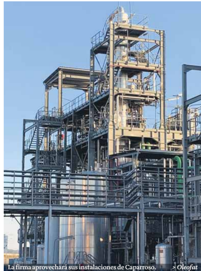
La firma aprovechará sus instalaciones de Caparros. > Oleofat
