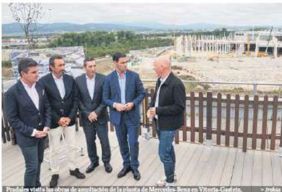
Pradales visita las obras de ampliación de la planta de Mercedes-Benz en Vitoria-Gasteiz. > Iratxe
